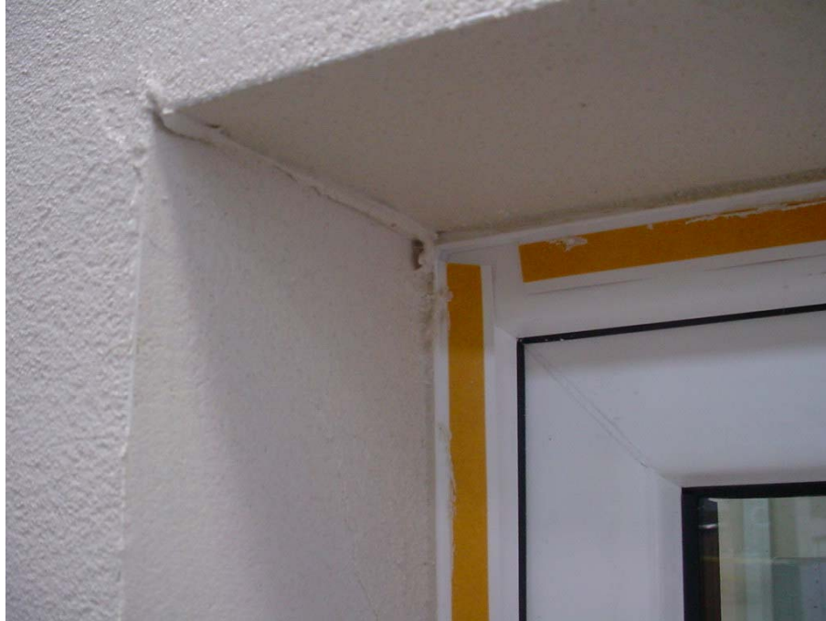
Bild 5 Oberes Eckdetail LAIBUNGSPROFIL AKKORDEON mit Gewebe (WDVS).
