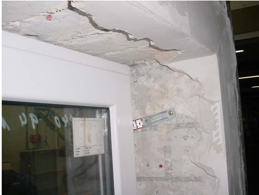
Bild 1 Befestigung des Fensters zum Baukörper mit Mauerankern.
