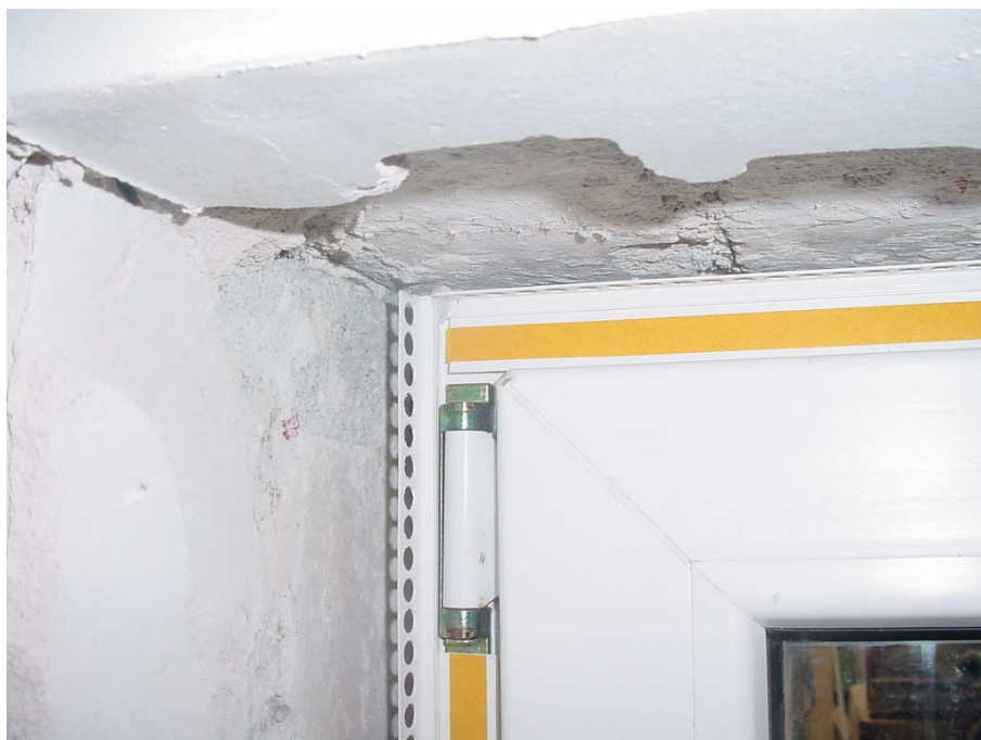
Bild 2 Obere Eckausbildung LAIBUNGSPROFIL AKKORDEON ohne Gewebe.
