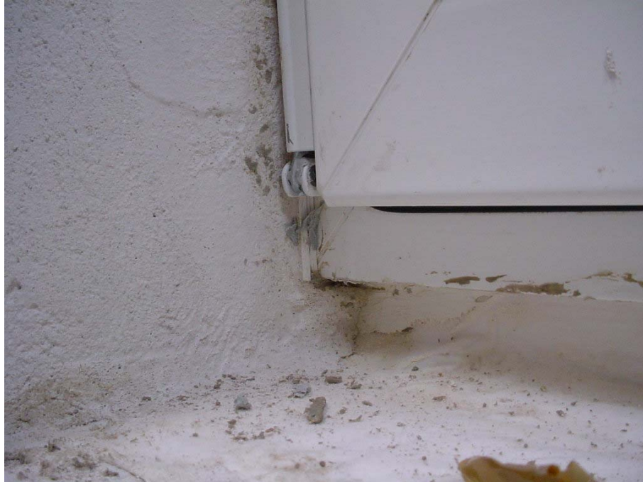
Bild 3 Untere Eckausbildung, im Brüstungsbereich (bereits eingeputzt).
