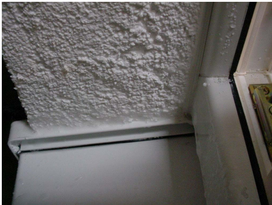
Bild 6 Unteres Eckdetail LAIBUNGSPROFIL AKKORDEON mit Gewebe im Übergang zur Fensterbank nach Fertigstellung des WDVS.
