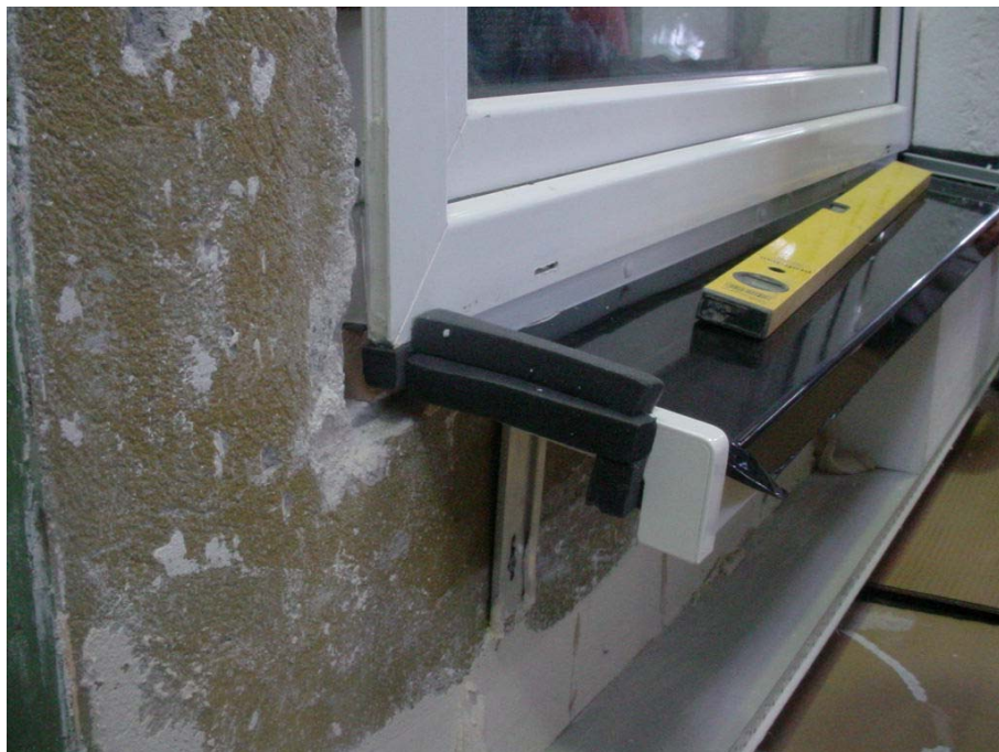
Bild 4 Einbau und Anschluss der Alu-Fensterbank an WDVS.
