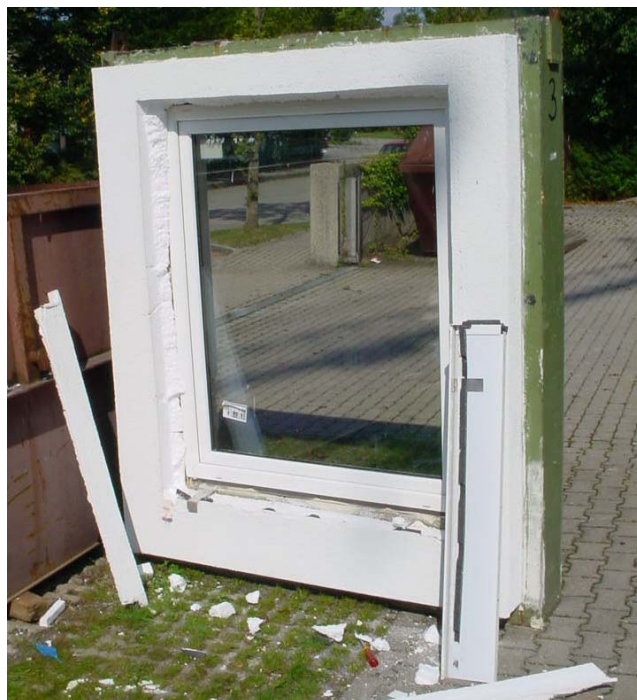
Bild 8 Nach Abschluss der Prüffolge äußere Leibungen zur abschließenden Untersuchung geöffnet.
