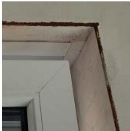
Rostschaden durch Abrieb der Verzinkung
